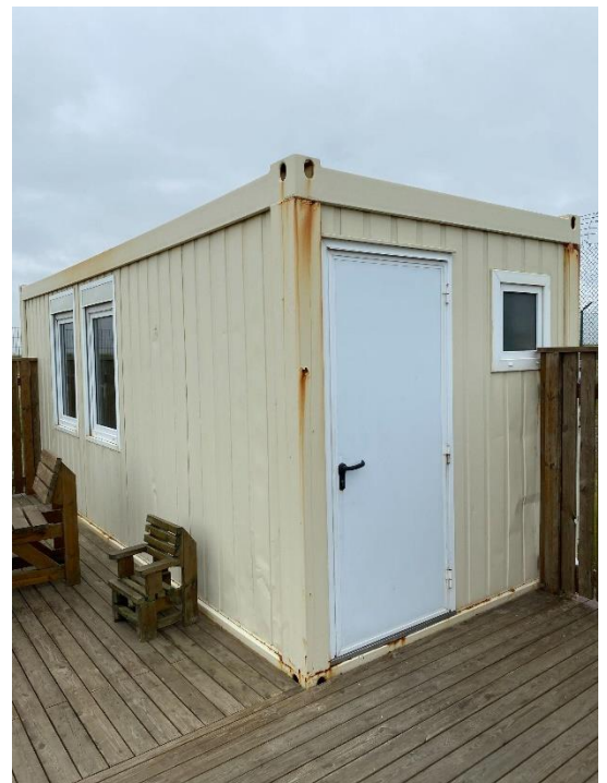
Mynd 5. Hér er útlit Barnakots að utan., Vel má sjá ryð og ásigkomulag húsnæðisins er ekki gott.
